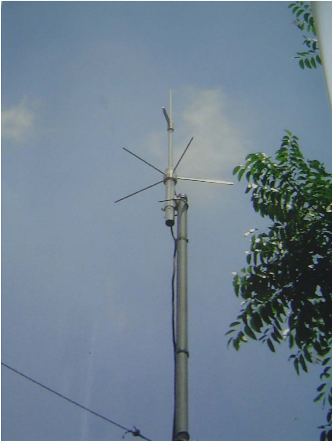
ภาพที่ 3.2 ง เสาอากาศส่งสัญญาณของหอกระจายข่าวแบบไร้สายอัตโนมัติ
