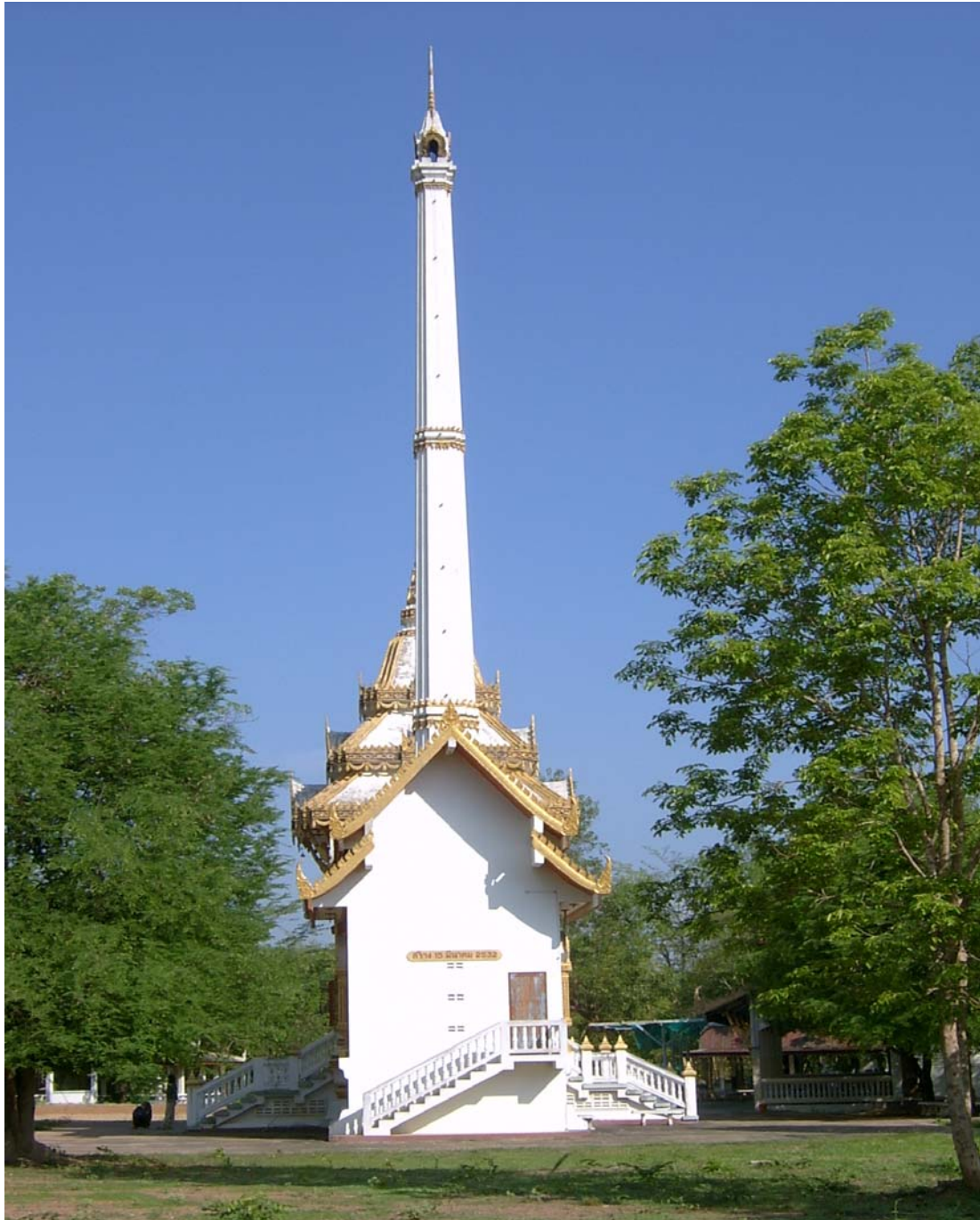
ลักษณะเมรุทั่วไปที่สร้างครอบเตาเผาศพแบบปิด
